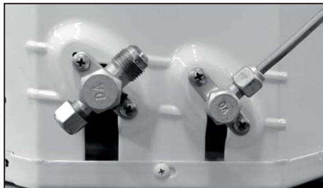
FIG. 49 - CONEXÃO DA LINHA DE EXPANSÃO DA UNIDADE CONDENSADORA
